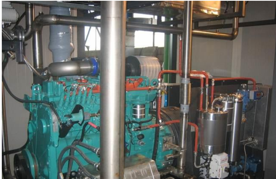
L'interno della cabina di un gruppo di produzione di energia elettrica-termica da 100 kW prodotto da Powertron. Il sistema può funzionare in media oltre 650 ore/mese continuativamente.
